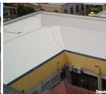
Substituição de cobertura e platibandas
